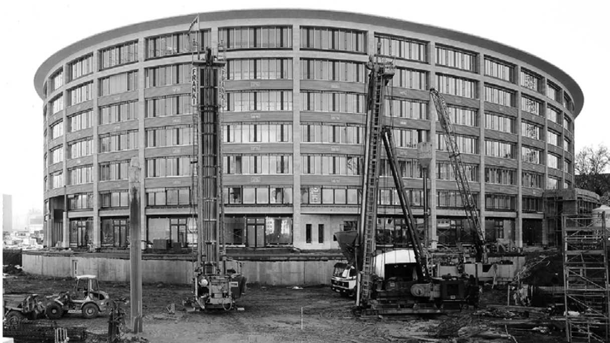
Bild 11: Gründungsarbeiten vor dem Bauwerk „Oval“
