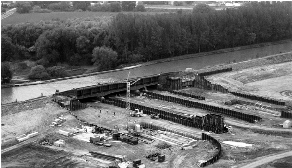
Bild 7: Bestehende Leineflutbrücke und im Bau befindliche neue Kanalbrücke
