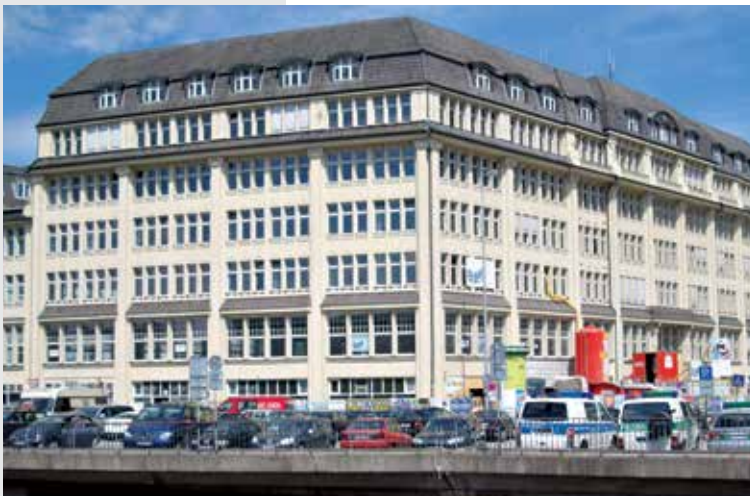
Ohnsorg-Theater, Hamburg (Mikropfähle)
