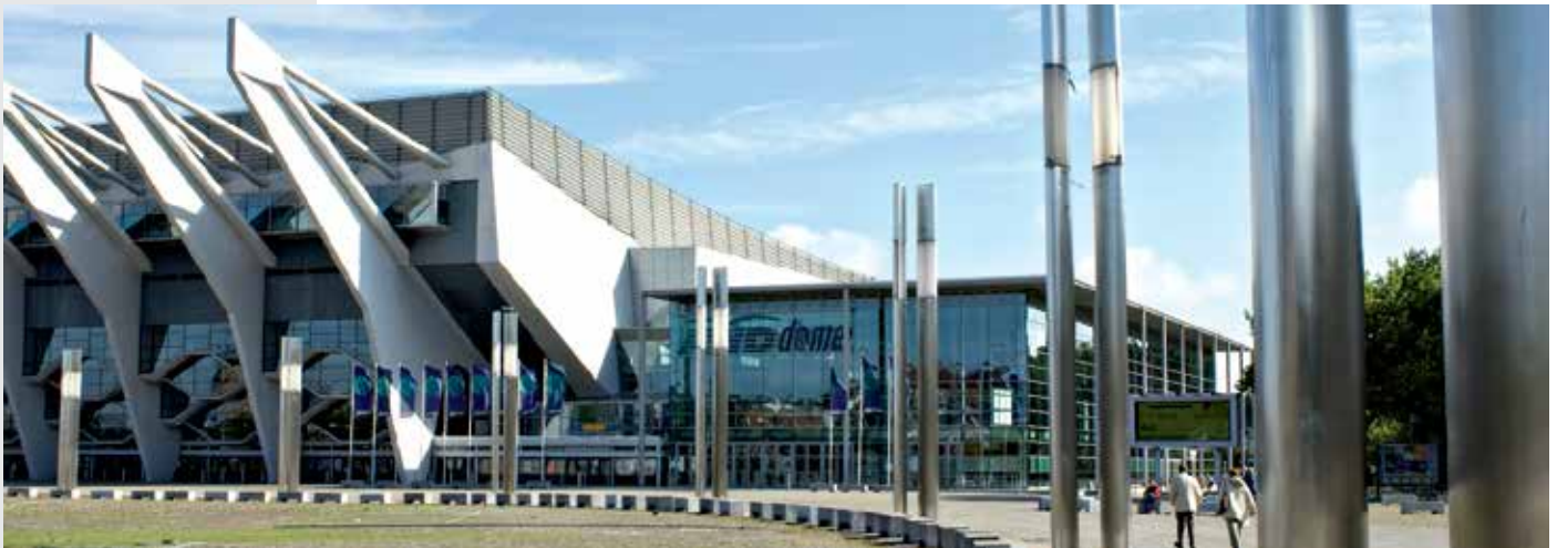
Stadthalle, Bremen (Stahlrohrpfähle)
