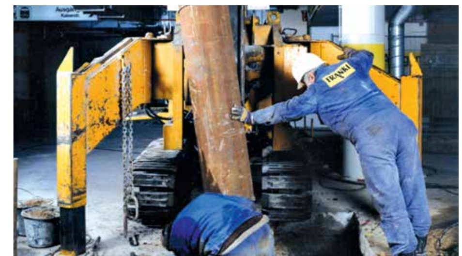
Pfahlerstellung unter beengten Verhältnissen, Kinocenter Gütersloh
