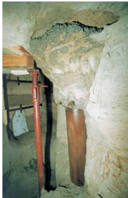
Freigelegter Presspfahl mit Stahlbeton-Pilzkopf unter dem Schulzentrum Bremen
