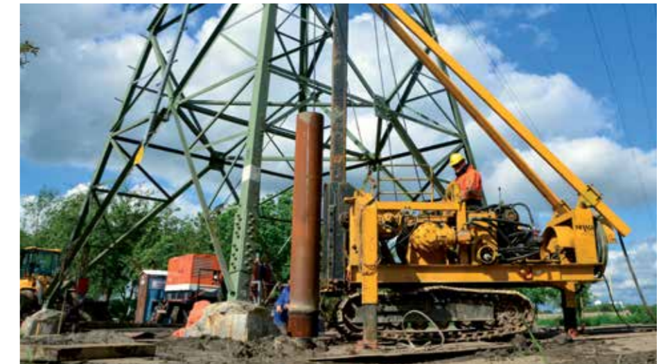
Herstellung im Bereich eines Stützenfußes
