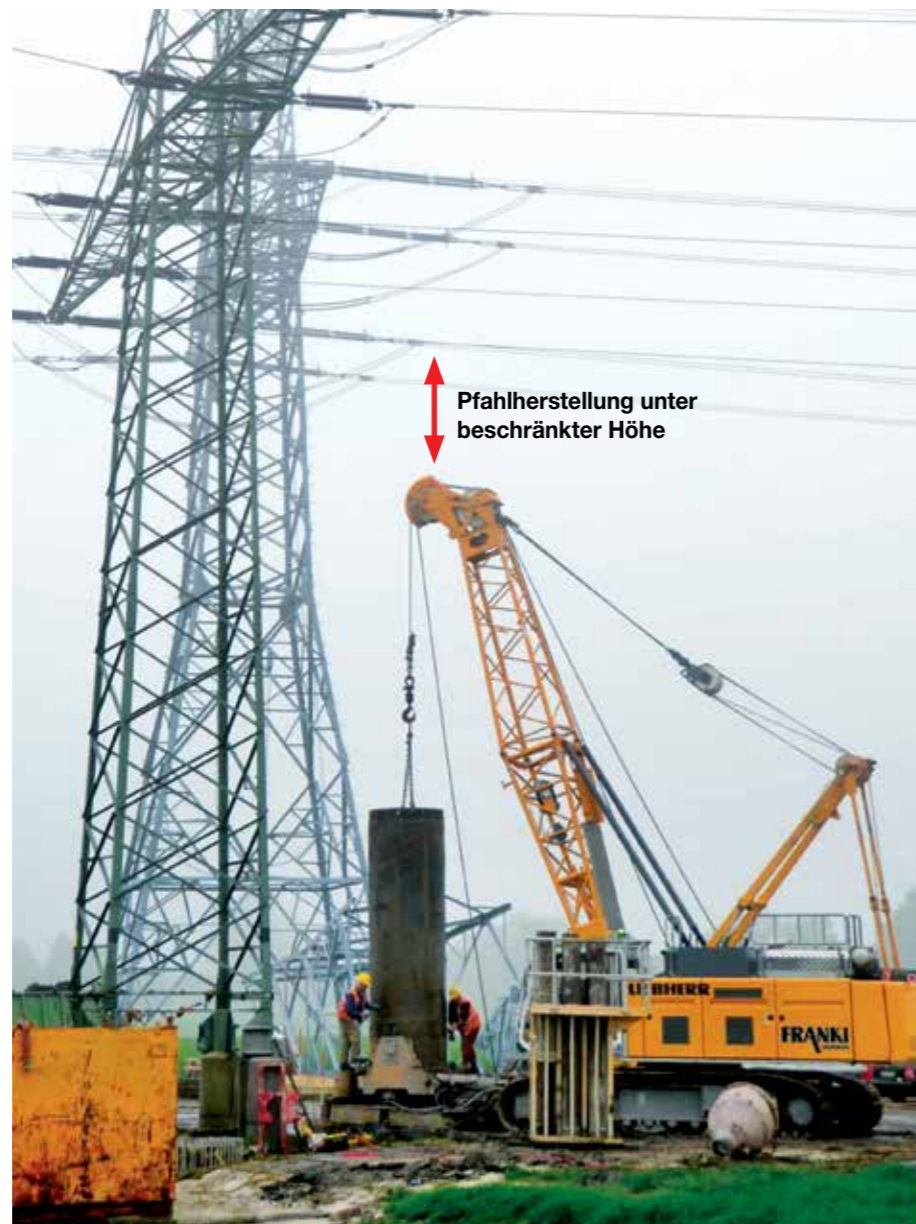
Herstellung der Großbohrpfähle unter den Stromleitungen
