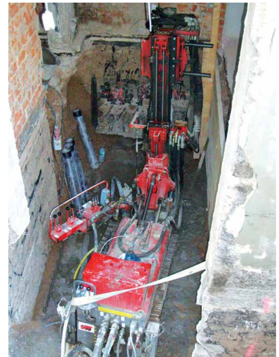
Pfahlherstellung Gesellschaftshaus im Palmengarten, Frankfurt/Main
