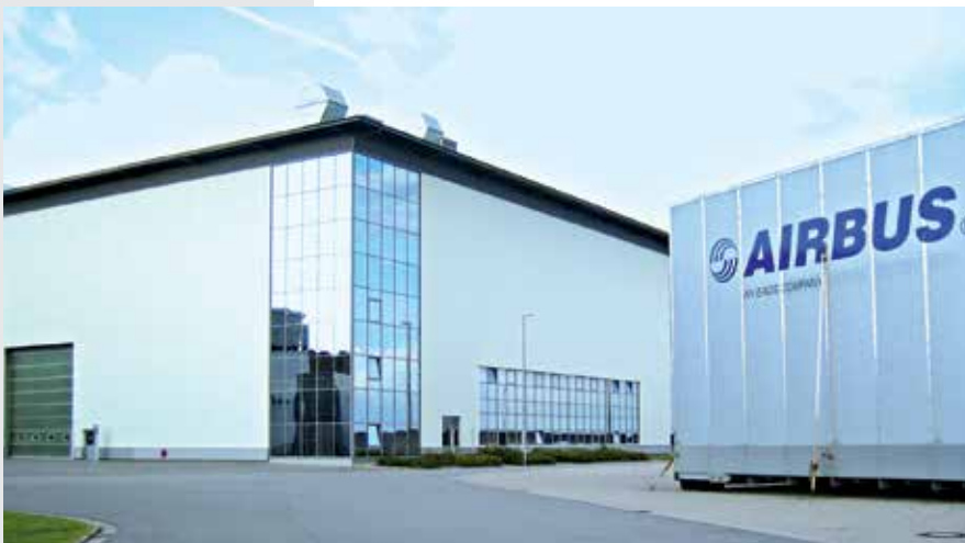
Airbus Produktionshalle, Nordenham (Atlaspfähle)
