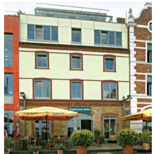
Hotel, Stralsund (Presspfähle)
