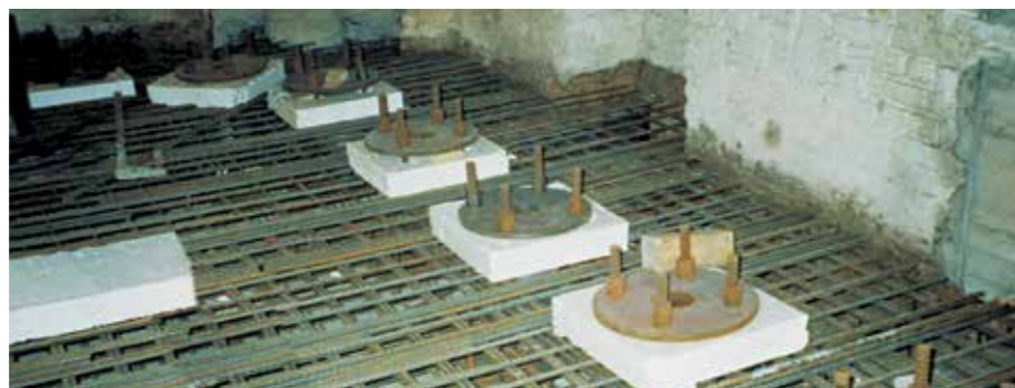
Eingebaute Verankerungselemente vor dem Betonieren der Sohlplatte
