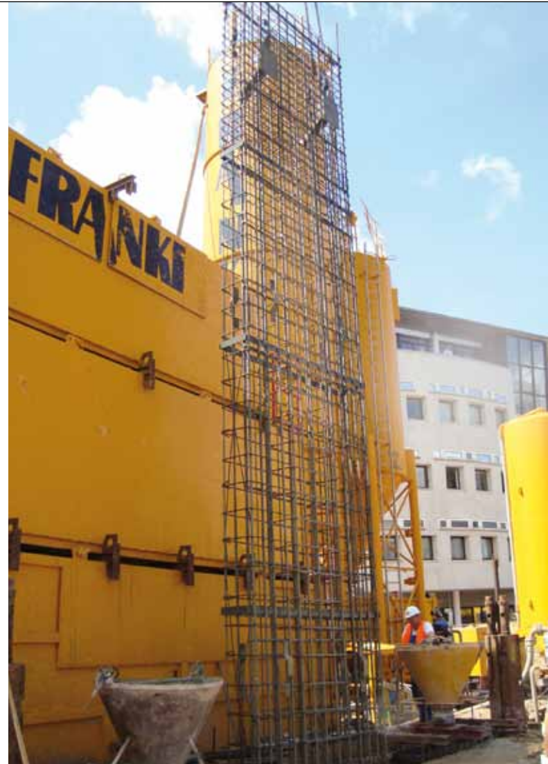
Einbau der Bewehrungskörbe in Hannover
