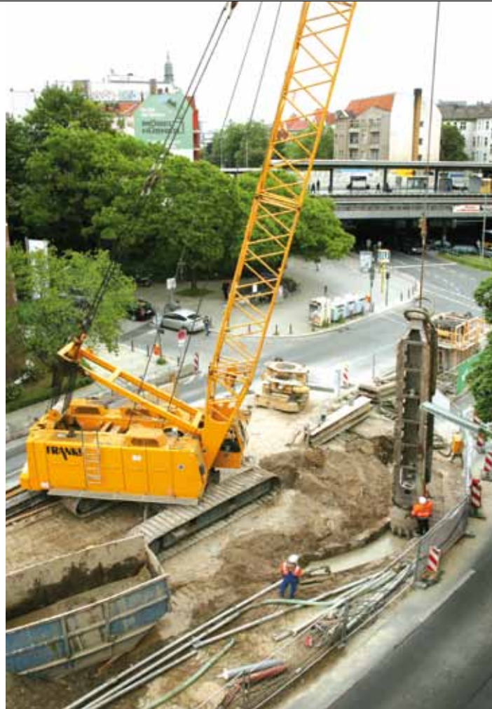
Herstellung der Schlitzwände auf engstem Raum
