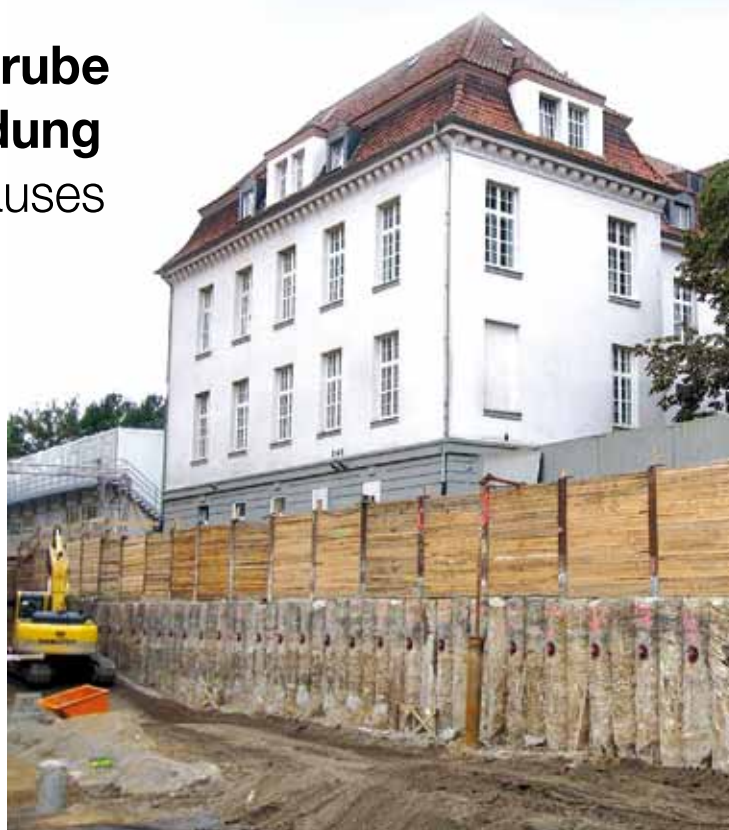
Krankenhaus Siloah, überschnittene Bohrpfahlwand mit Steckträgern
