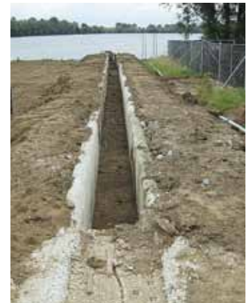
Leitwände aus Fertigteilelementen
