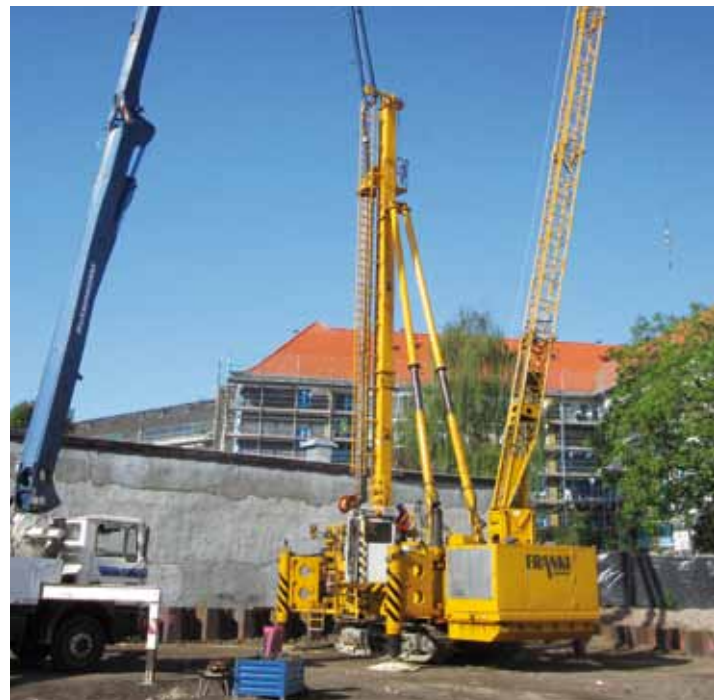
Betonieren der Atlaspfähle in der Baugrube
