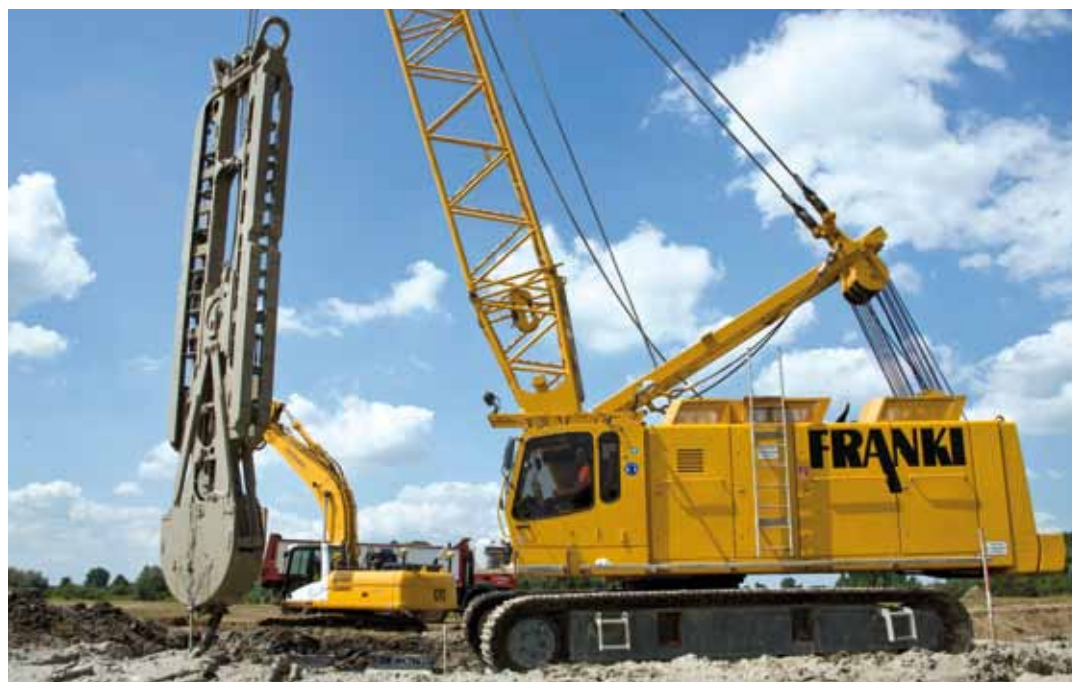
Herstellung einer Dichtwand als Deponieumschließung in s'-Hertogenbosch (NL)
