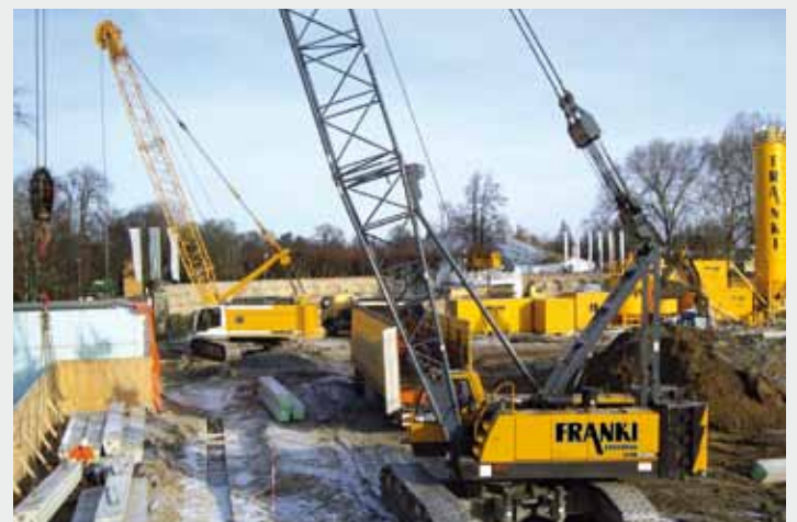
Herstellung der Dichtwände, Einstellen der Fertigteil-elemente (Vordergrund)
