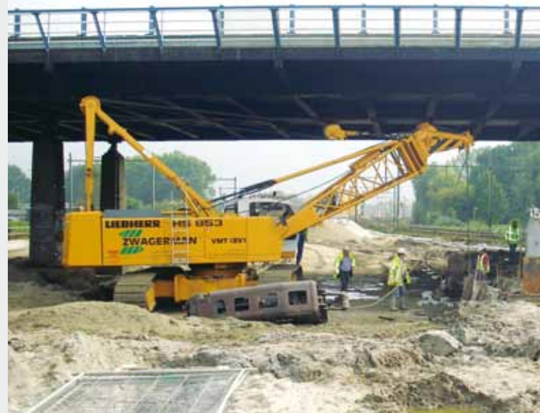
Herstellung der Schlitzwand unter beschränkter Bauhöhe von 7,0 m
