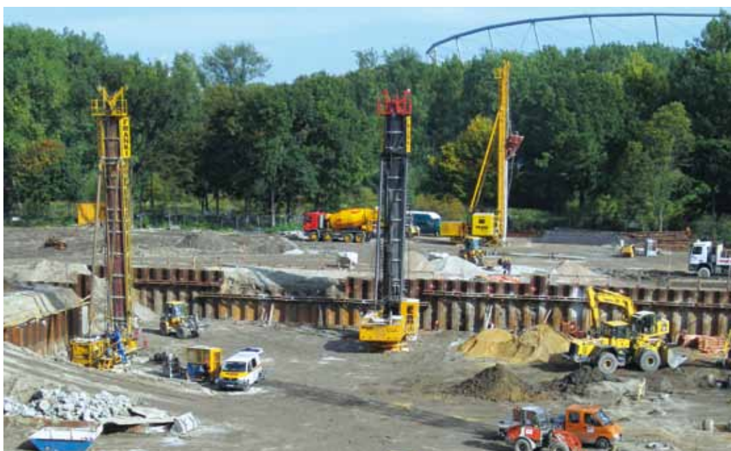
Drei FRANKI-Rammen gleichzeitig auf dem Krankenhausgelände im Einsatz
